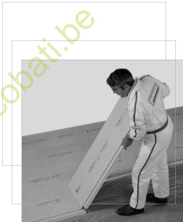
De geluids- en warmte isolerende FERMACELL vloerelementen afmeting 150 x 50 cm. In verschillende uitvoeringen leverbaar.
