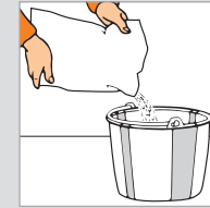
Afbeelding 23: FERMACELL voegengips in het water strooien
